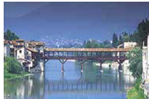
De 16de-eeuwse houten brug van Palladio in Bassano del Grappa
