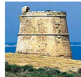
Martellotorens liggen overal op Menorca. De ronde torens met dikke muren en een plat dak zijn door Britten of Spanjaarden gebouwd.
