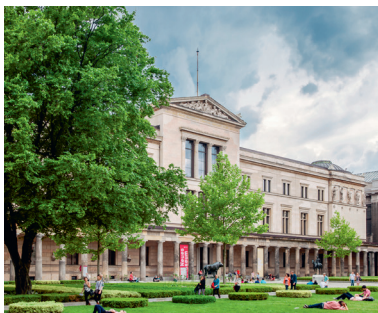
↑ Het museumgebouw, ontworpen door Friedrich August Stüler
