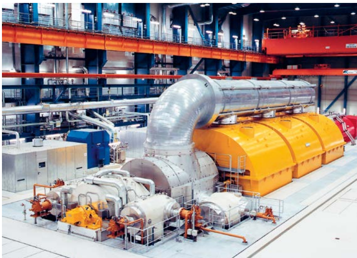
FIGUUR 1.13 Hal met turbogeneratoren
