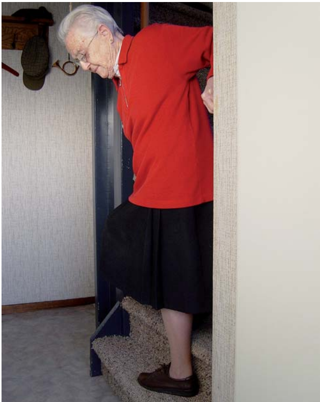
Voorbeeld van een niet-adequate leuning; foto uit het trappenlabonderzoek
