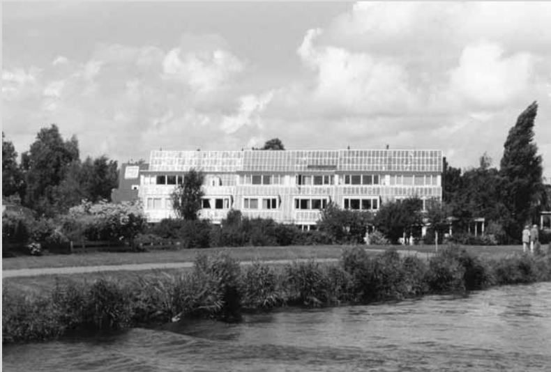
Figuur 1.14 Optimaal gebruik zonne-energie (zonnepanelen in de dakopbouw)
