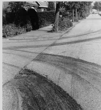
Figuur 1.4 Viskeuze vervorming in asfalt
