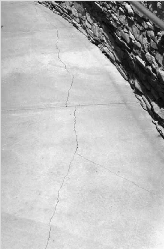
Figuur 1.6 Droogscheur in beton (oppervlaktescheur in voetpad, met stortnaad)
