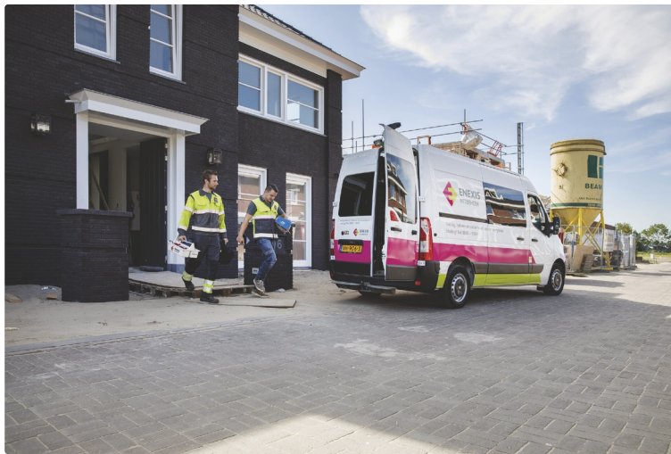
Figuur 3 Monteurs leggen een huisaansluiting aan. (Bron: enexis.nl)
