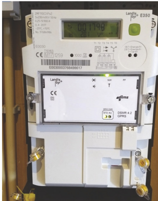
Figuur 10 Digitale kWh-meter (Bron: J. Gerrits)
