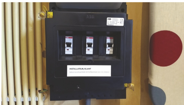
Figuur 9 Hoofdbeveiliging van een driefase-installatie (Bron: J. Gerrits)
