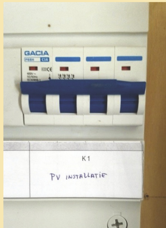
Figuur 6 Extra eindgroep voor een pv-installatie (Bron: J. Gerrits)
