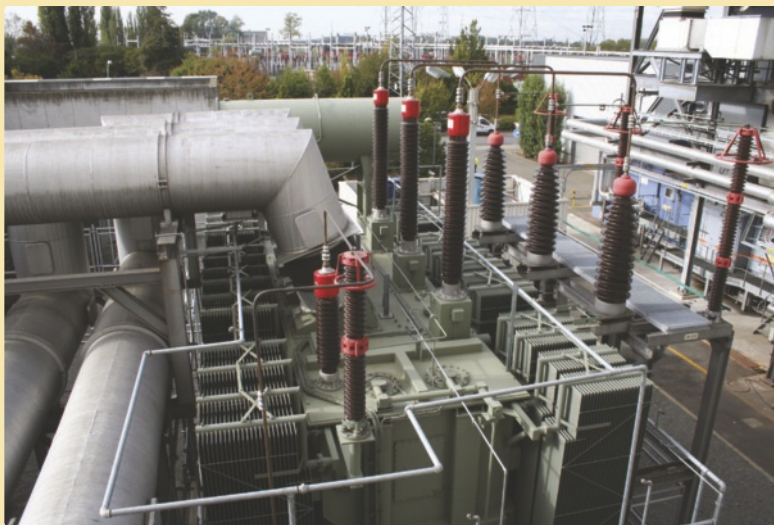
Figuur 1 Generatortransformator en doorvoerisolator (Bron: Philippe Mertens/Tekenbureau Frans Hessels)
