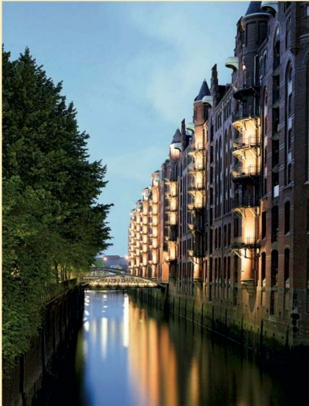
Kanalen en grachten doorsnijden – zoals hier aan de Holländischer Brook – de Speicherstadt
