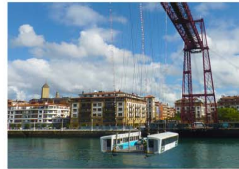
De gondel onder de brug vervoert auto's en voetgangers.
