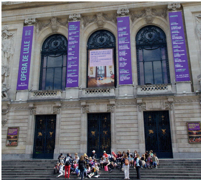
Operagebouw, aan de Place du Théâtre
