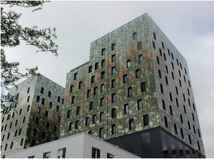
De wijk Euralille staat vol interessante hedendaagse architectuur; hier Le Vérose, van architect Dominique Perrault
