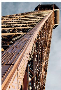
Bijna 10.000 ton ijzer was nodig om de Eiffeltoren te bouwen
