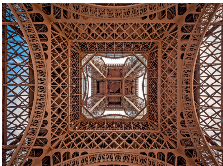
Inkijktje in de inventieve constructie van de Eiffeltoren
