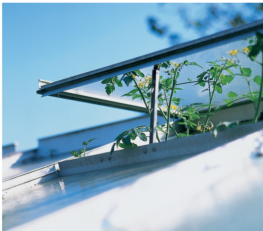
Kies een kas met voldoende luchtinscapaciteit bovenin. De opstijgende warme lucht kan de kas verlaten zonder tocht te veroorzaken.
