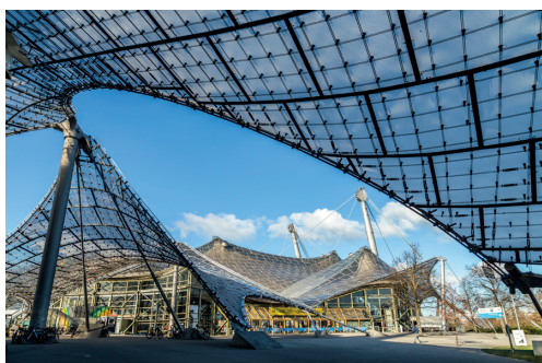
Glazen dak over het Olympische zwembad te München, Duitsland.
