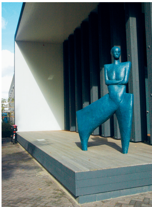
Overstek bij het Search-kantoor in Amsterdam: hierdoor ligt (een groot deel van) het raam in de schaduw.
