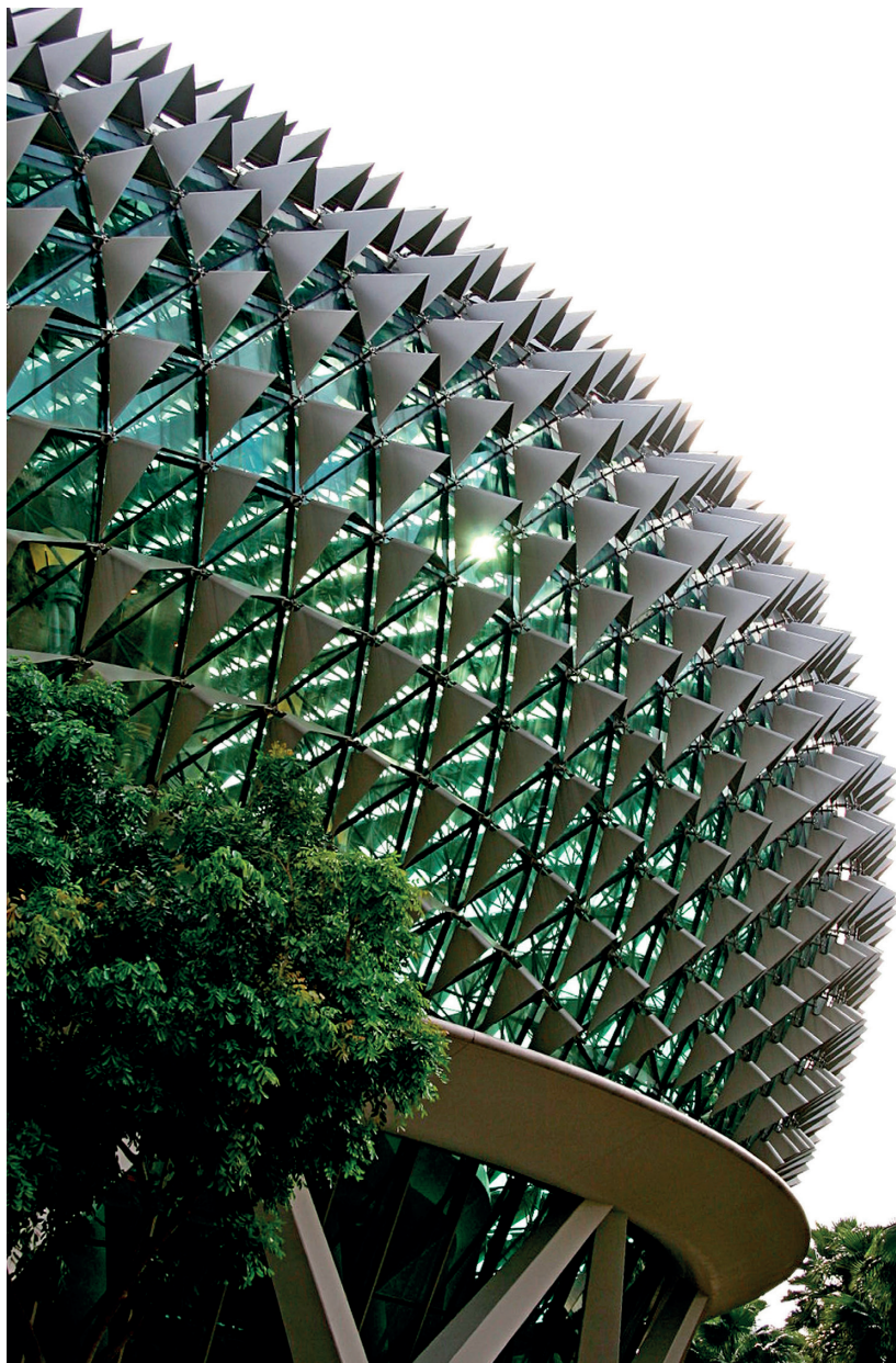
Kleppen op het Esplanadegebouw in Singapore voorkomen zonstraling door de verder volledig glazen schil.
