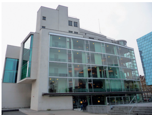
Het Glaspaleis te Heerlen, ook nu nog een toonbeeld van modernisme.
