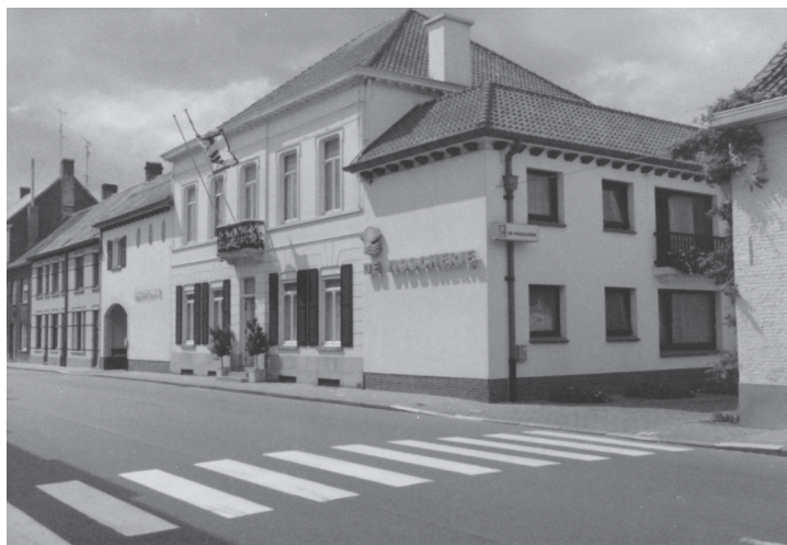
Feestzaal de Visscherie gezien vanaf de straatkant, 1975.
