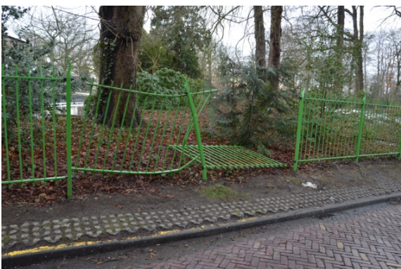
Beschadigd hek door een aanrijding.
