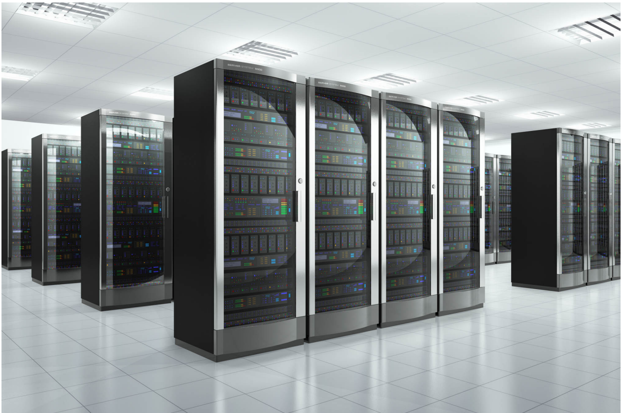
Een datacenter met meerdere racks, geplaatst in rijen, 'rows' genaamd.
