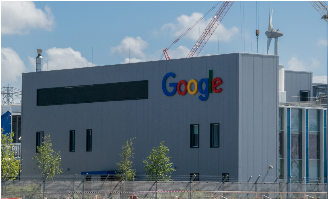
Een hyperscale datacenter in de Eemshaven.
