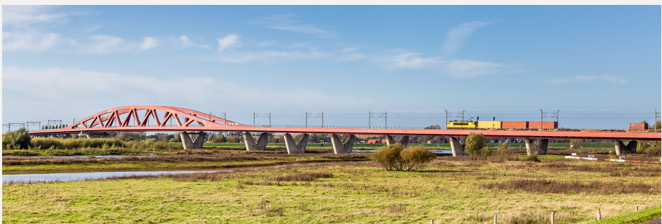
Project IJsselspoorbrug bij Zwolle.
