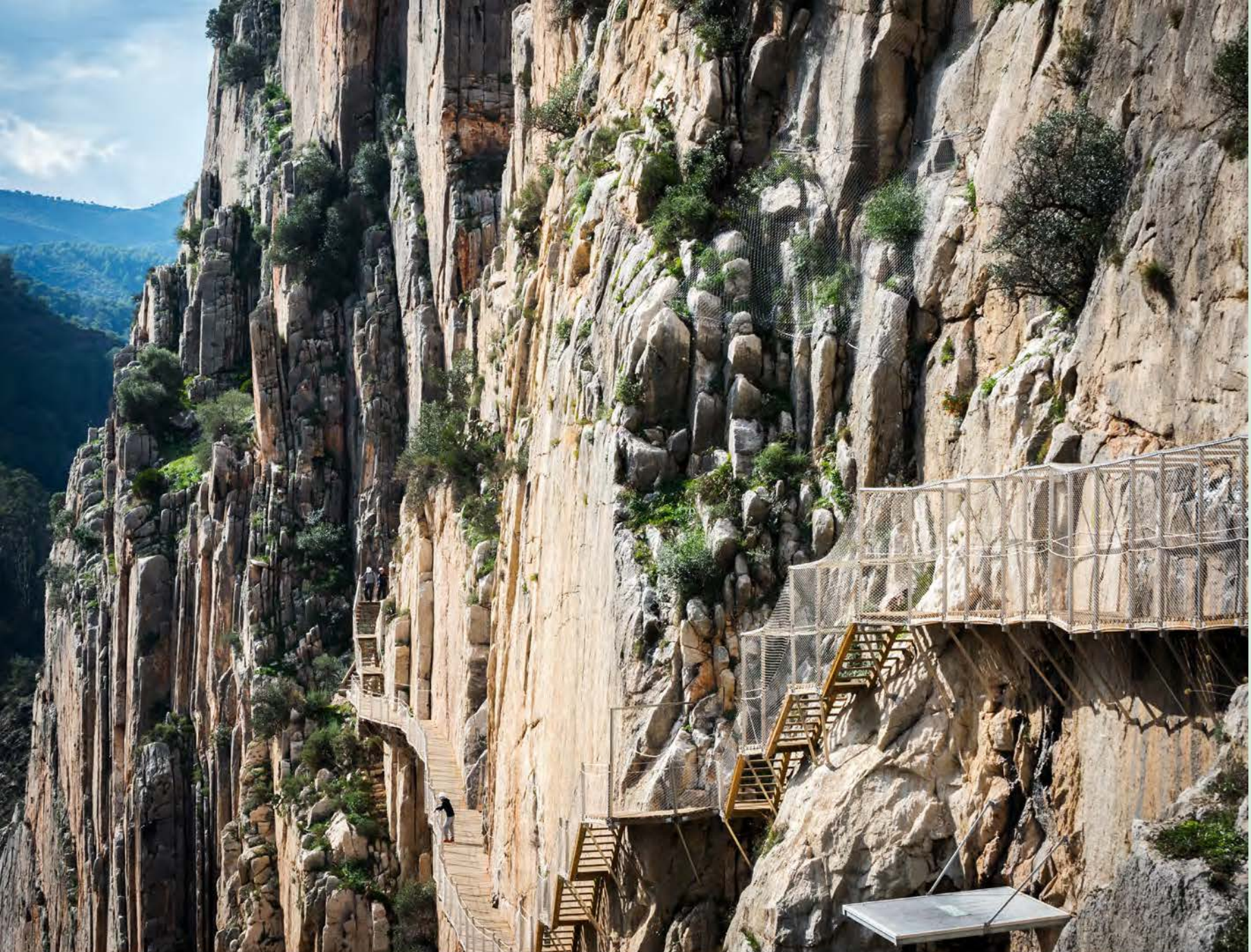
↕ Trappen liggen tegen de rotswand aangeplakt.
