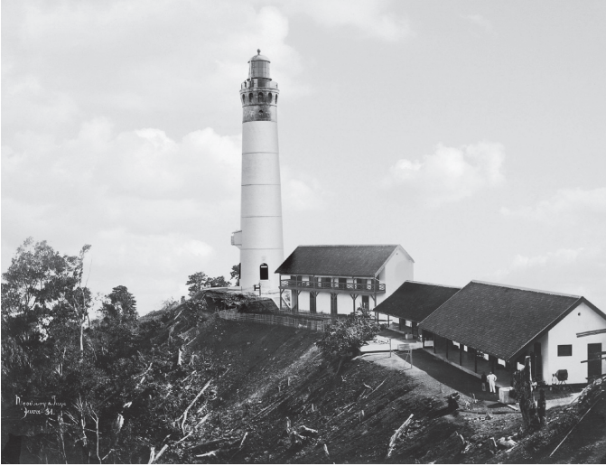
De Willemstoren op Pulau Breueh, 1876
