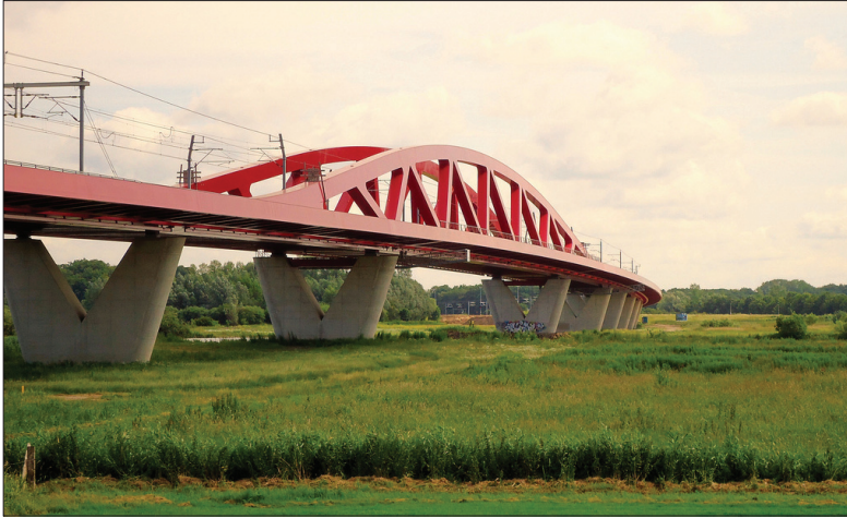
Project IJsselspoorbrug bij Zwolle
