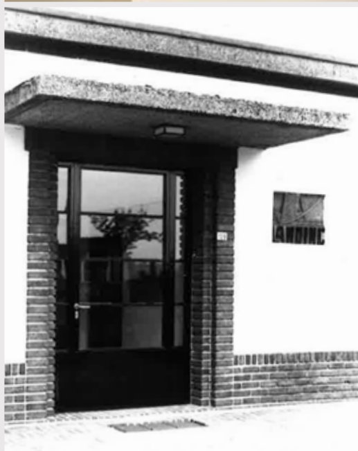
Boven: De horizontale banden op de eerste verdieping. Onder: De inkom met betonnen luifel. (1978)
