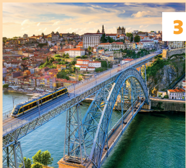
Ponte Luís I ★★
