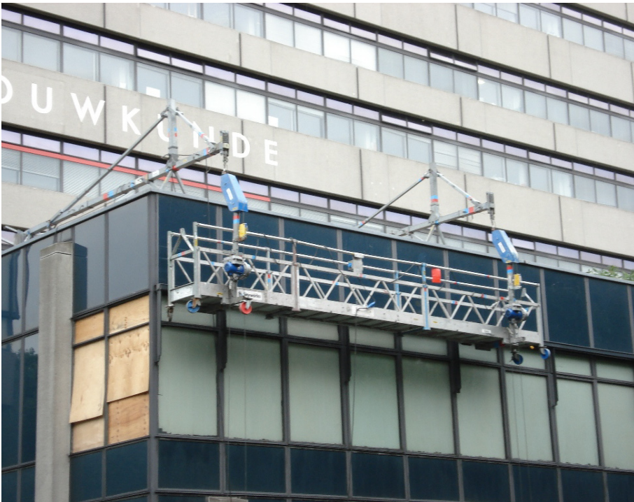
Figuur 23 Mobile gondelinstallatie voor laagbouw
