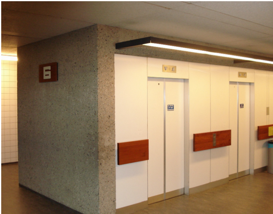
Figuur 11 Schijf tegen de liftschacht
