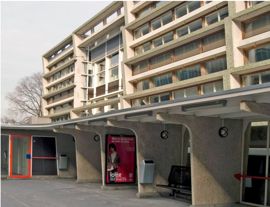
Figuur 7 Aanzicht Noordgevel vanaf het stationsperron
