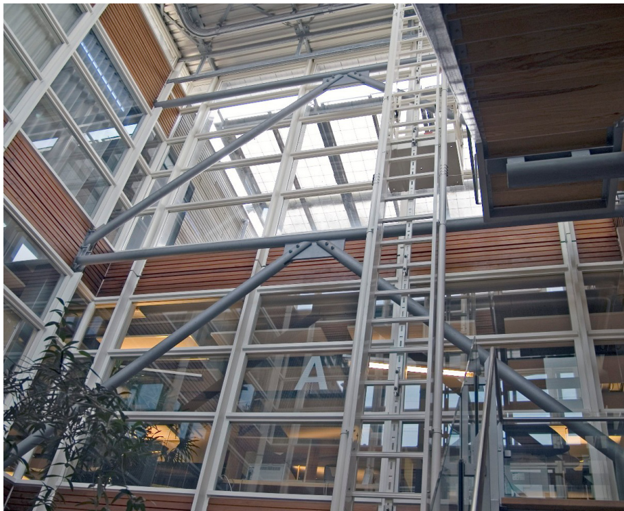
Figuur 9 Stalen windverbanden in het atrium
