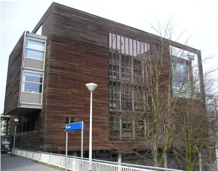
Figuur 6 Oostgevel vanaf stationsperron
