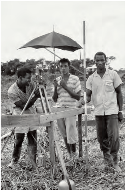
Landmeters van Lareco, een dochteronderneming van de Nederlandsche Heidemij, 1961. Terwijl de landmeter ingespannen door zijn theodoliet tuurt, houdt een collega een paraplu vast om de zon uit de blik van de landmeter te weren. De man rechts hoort normaal met zijn jalon (stok) het te meten punt te markeren, maar staat nu speciaal voor de foto pal voor de landmeter. Lareco was in deze jaren actief als aannemer en ingenieursbureau. Bij de bouw van de sluis en brug bij Uitkijk werkte Lareco samen met Van Heese-wijks Aannemingsbedrijf.
