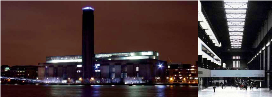
Interventie Tate Modern, Londen, architecten Herzog & De Meuron Intervention Tate Modern, London, architects Herzog & De Meuron
