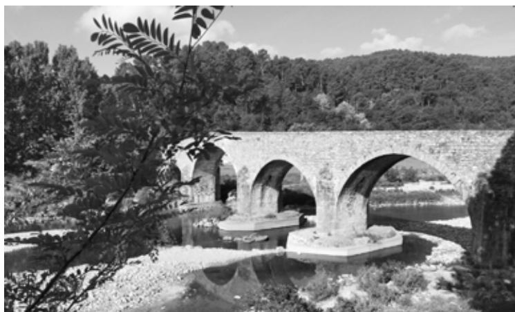
4. De oude brug over de Gardon
