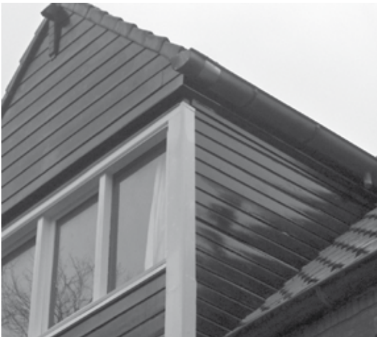
Illustratie 20. Gecorrigeerde, verlengde regenwaterafvoer
