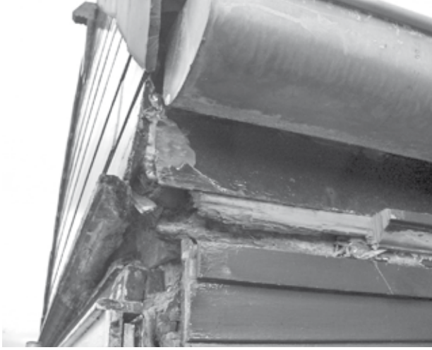
Illustratie 19. Consequenties van het verkeerd plaatsen van de regenwaterafvoer
