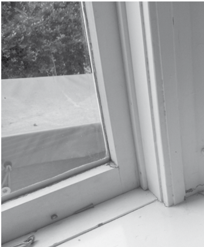
Illustratie 16. Linkerraam (niet afgekit)
