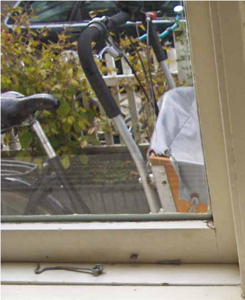
7. Linker raam (niet afgekit).
