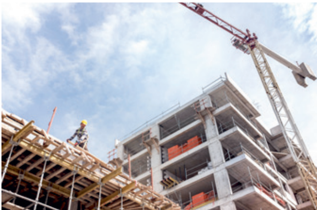
Figuur 1.2 Stadhuis in aanbouw.
