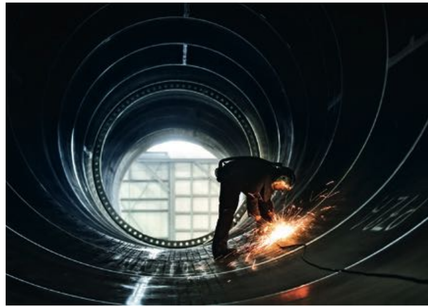
Lasser in een windturbinemast
