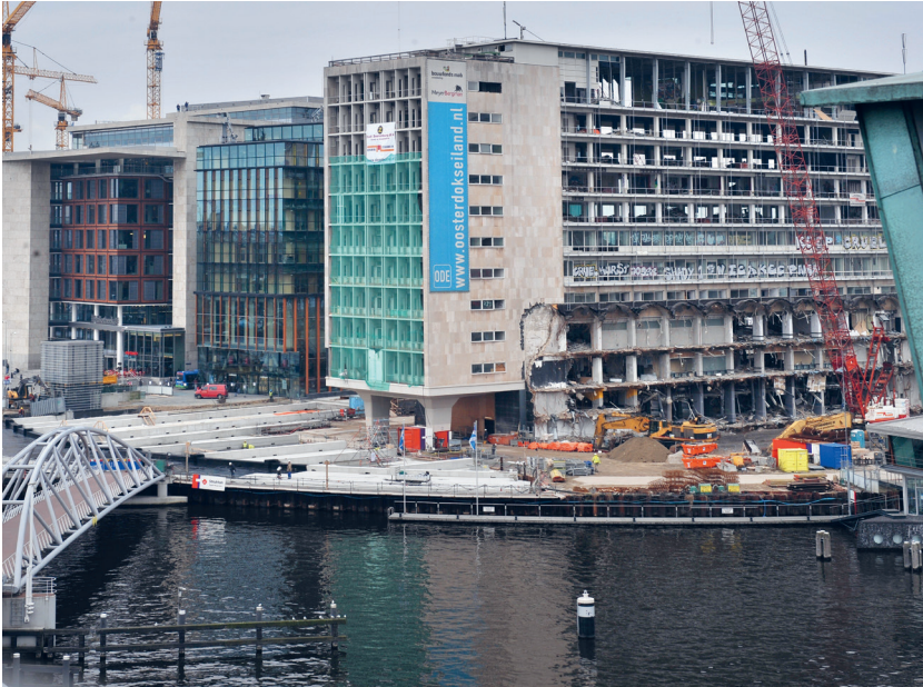
Afbraak van het Stadspostkantoor (rechts op de foto) op het Oosterdok, 2010. (D. Kransberg, Collectie Stichting IJbeeld, SAA)
