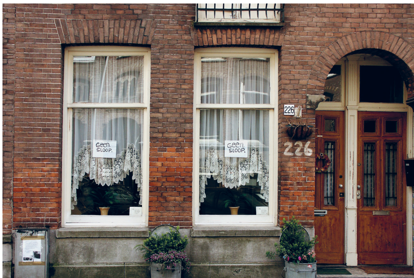
Van Ostadestraat 226, bestemd voor sloop, 2004. (M. Alberts, SAA)
