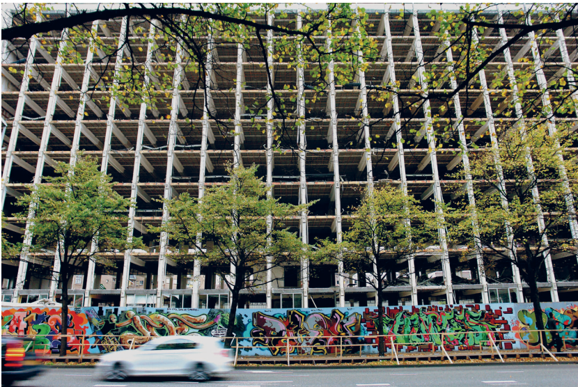
Sloop van het Wibauthuis aan de Wibautstraat, 2007. (M. Alberts, SAA)
