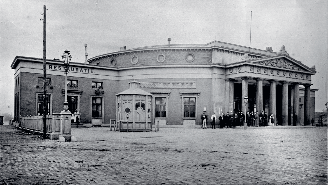
Station Amsterdam Willemspoort gelegen tegenover de Willemspoort of Haarlemmerpoort. Het HIJSM-stationsgebouw in de neoclassicistische stijl kwam gereed in 1843 en deed dienst tot 1878.
