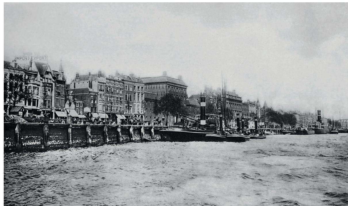
Een mengeling van kantoren, woonhuizen en koffiehuisen aan de Boompjes rond 1910
