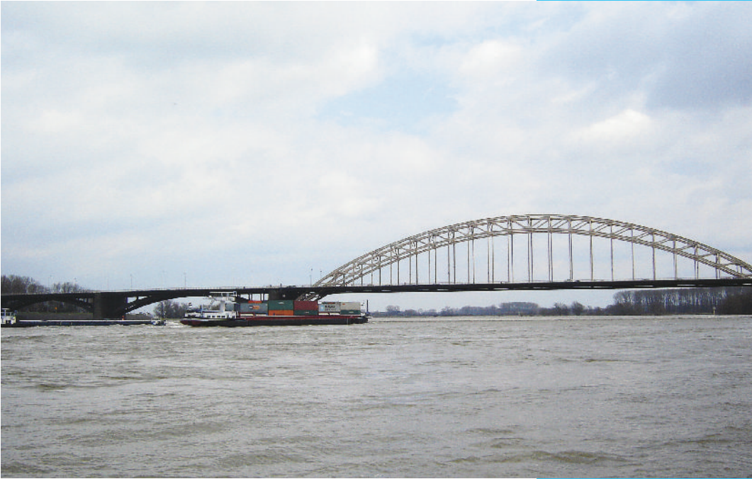
de rivier de Waal met de brug bij Nijmegen
