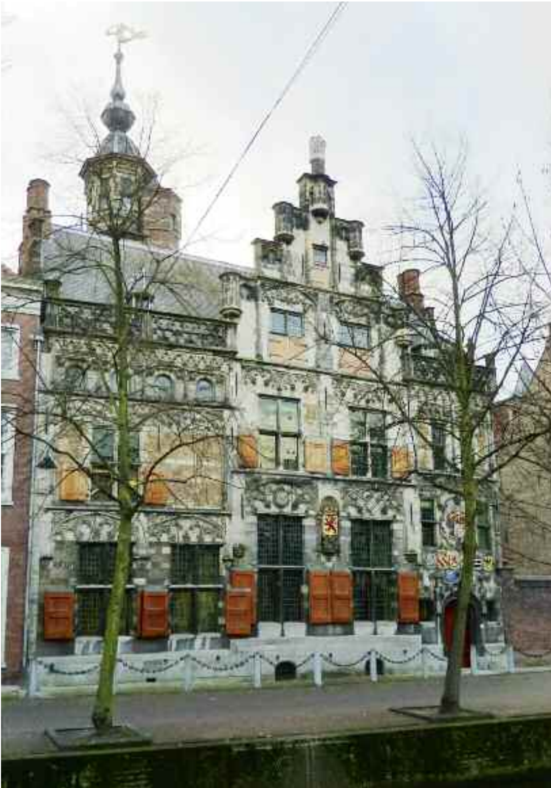
De bijzondere voorgevel van Oude Delft 167 overleefde de stadsbrand. De wapenschilden boven de ingang werden in de 17de eeuw door het Hoogheemraadschap Delfland aangebracht. (wfw, MD)
