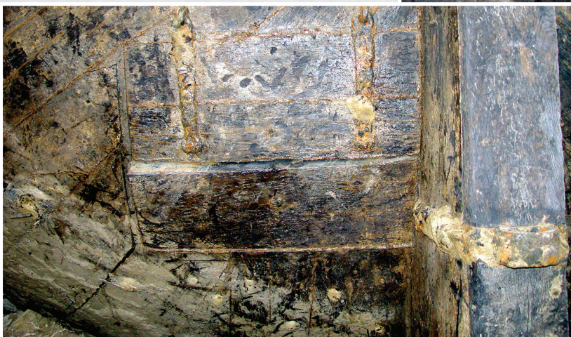
Fig. 5: Laadpoort van het touwwrak (OVM12) uit het Oostvoornse Meer (foto RCE). De afmetingen bedragen 40 bij 34 cm.
