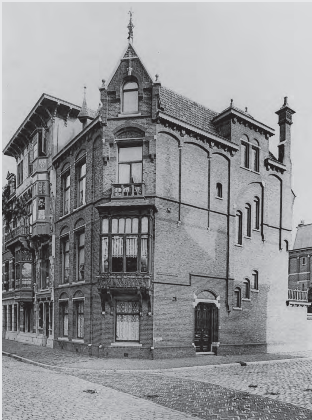
Het hoekhuis is het Woonhuis Teljer (1895); links daarvan het eigen woonhuis van Mutters (van 1897 tot 1915) (Schueler 1916).
