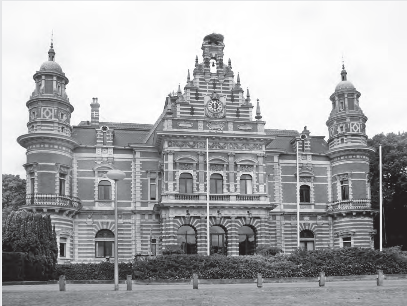
Kasteel Oud-Wassenaar, Park Oud Wassenaar 1, Wassenaar (1876-1879), 2015 (foto B. Verbrugge).
