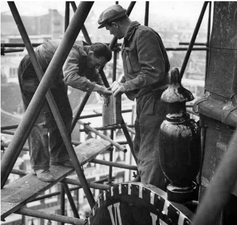
Renovatie werkzaamheden aan de Munttoren (1951).
