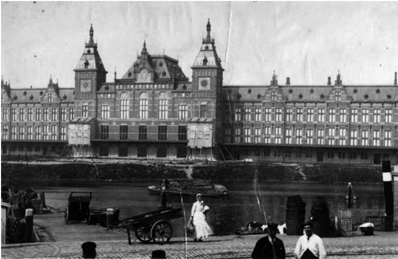
Centraal Station in aanbouw (1889).
