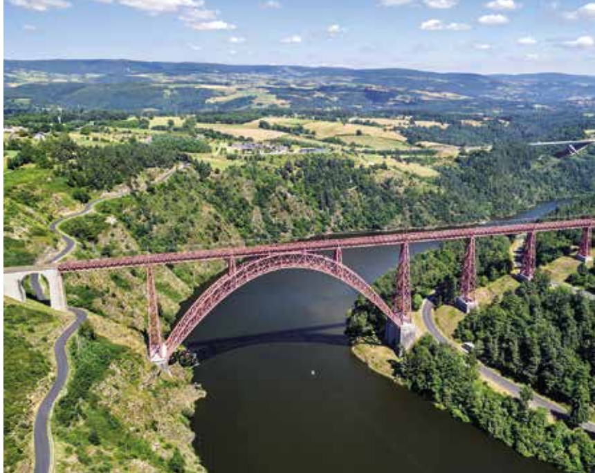
De Gorges de la Truyère en het door Gustave Eiffel gebouwde viaduct van Garabit A. Chicurel/hemis.fr
