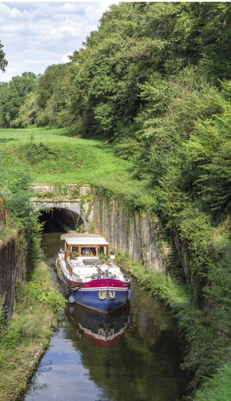
De Vouîtes de la Collancelle, een tunnel in het Canal du Nivernais, bij Corbigny Cr. Guy/hemis.fr
