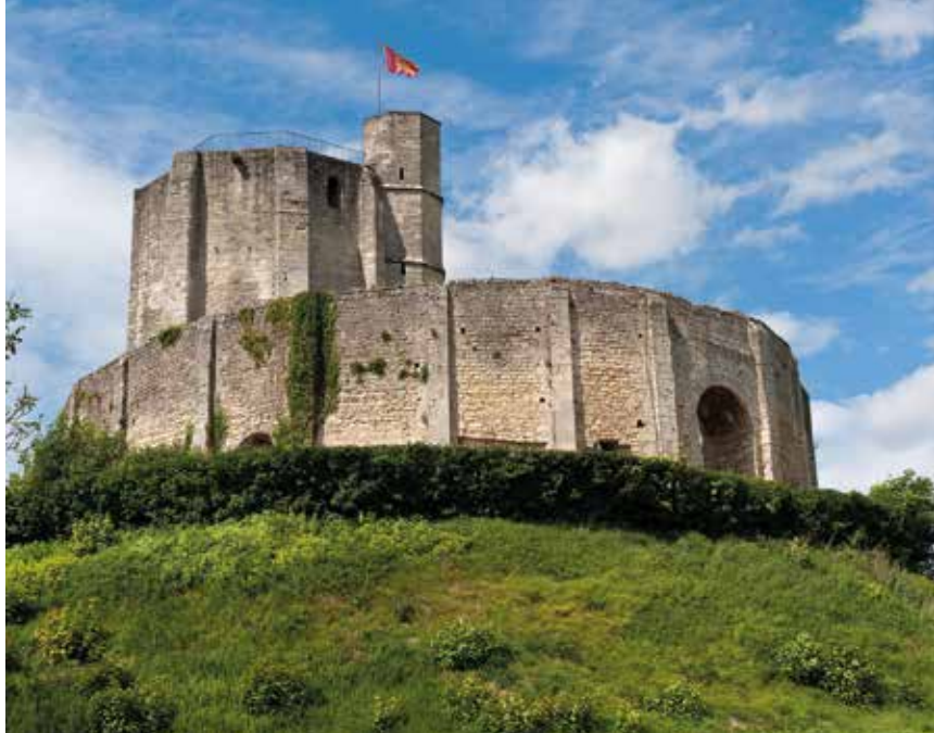
De donjon van het Château de Gisors is gebouwd op een motte.
