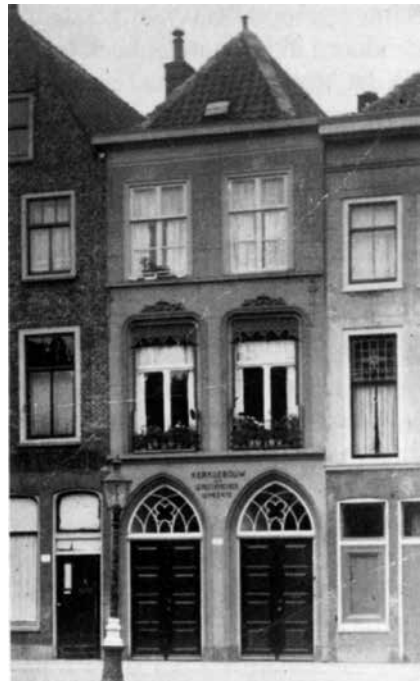
Exterieur kerkgebouw Gereformeerde Gemeente te Leiden.
