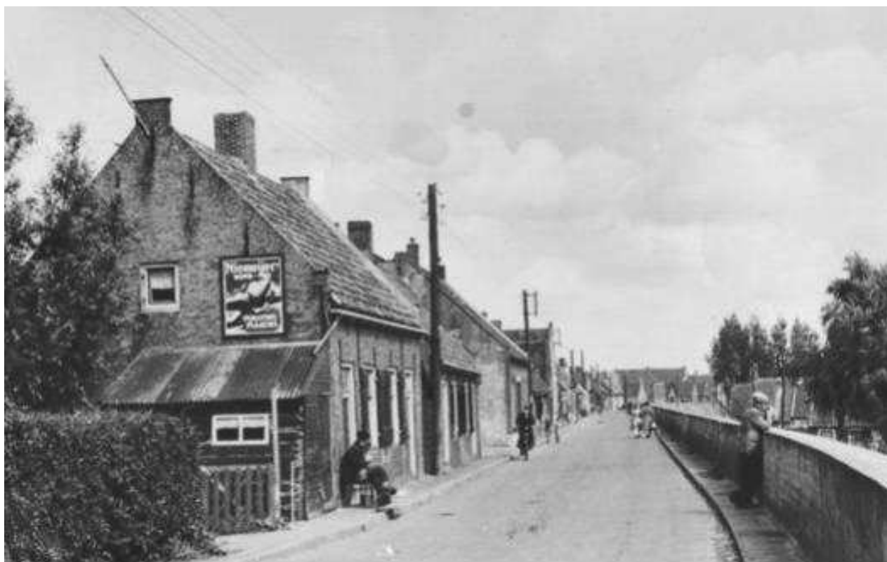
Rechts de waterkerende muur/ beer langs het Weverseinde.
