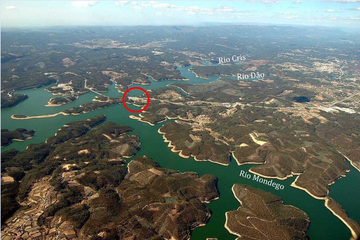
FIG. 44 – VISTA AÉREA DA ALBUFEIRA DA AGUIEIRA E DA IMPLANTAÇÃO DO RESTAURANTE “A LAMPREIA” (DELIMITADO NO CIRCULO VERMELHO) NA ÁREA DE SERVIÇO DO IP3 NO CHAMADOURO (3440-007 CHAMADOURO), EM SANTA COMBA DÃO, EM 23/12/2022.
