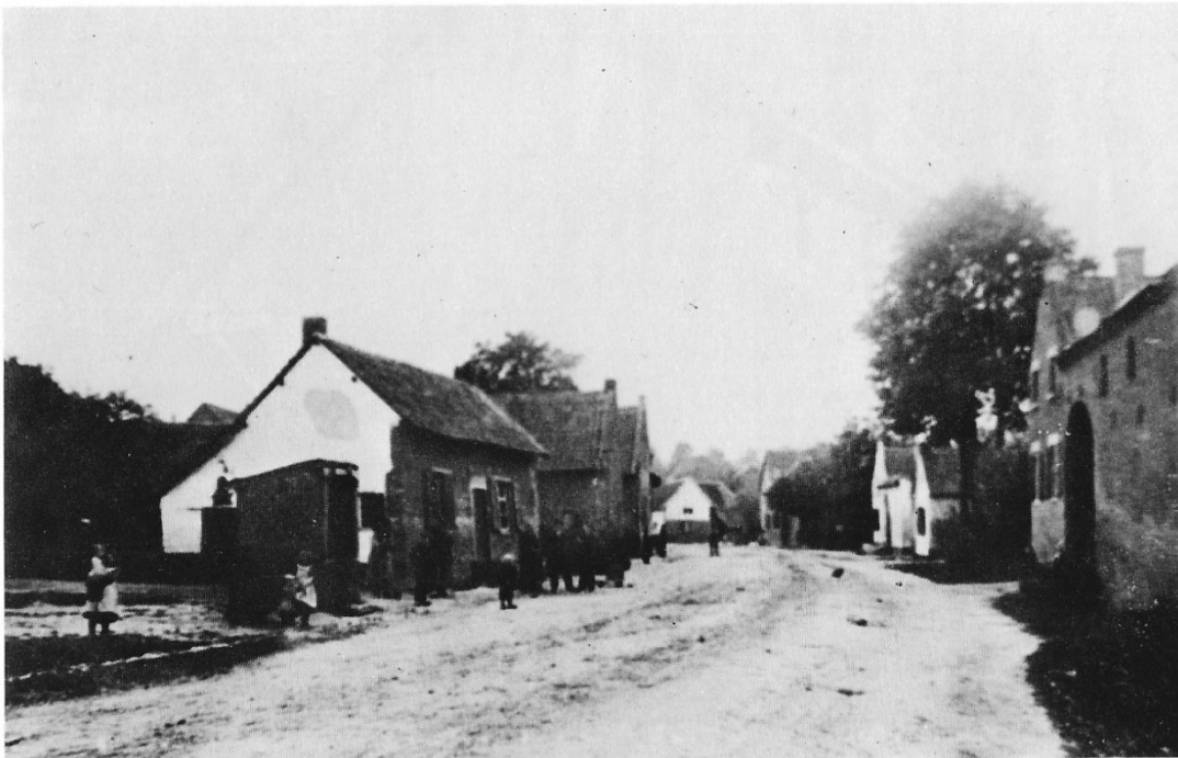
Dorpsstraat omstreeks 1895. De weg is onverhard en naar twee kanten aflopend, om het water in de 'ziepen' af te voeren. Geheel links is de put van Meulenberg, één van de vier putten in het dorp.
