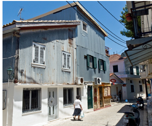
Aardbevingsbestendige huizen met golfplaat in Lefkada-stad. Foto Hans de Visser]
