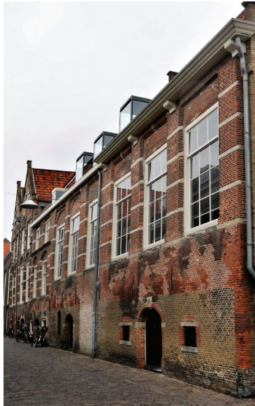
Berckepoort, zijde Nieuwstraat
