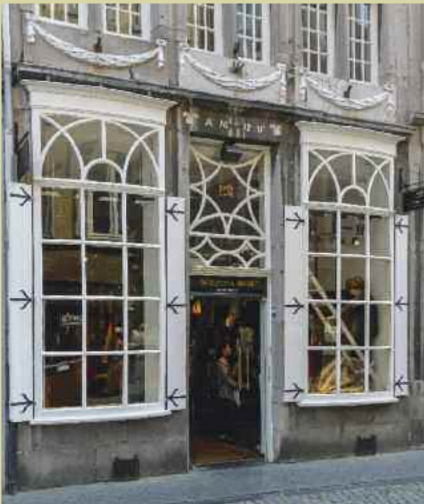
36 Maastricht, Muntstraat 1. Pand uit 1612; de licht gebogen houten etalagekasten dateren uit het midden van de 19de eeuw.
